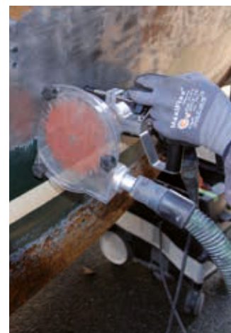
Usuwanie farby z regulowaną prowadnicą i osłoną przeciwpýłową
